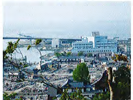
「2階まで水に浸かり、地盤沈下した市立病院は取り壊すことに・・・」
